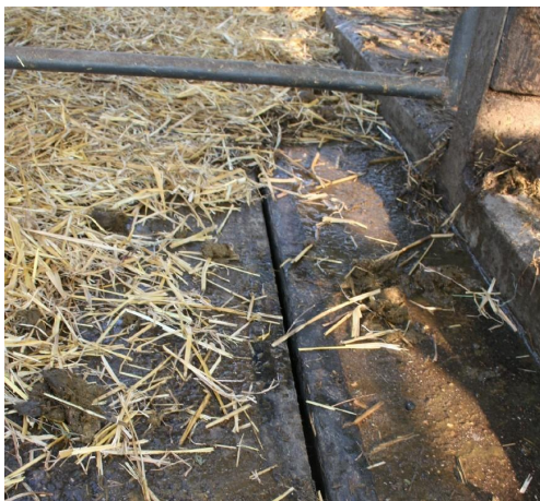
Abb. 3: Die Schlitzrinne sorgt für sichere Entwässerung und weitgehend trockene Laufflächen.
