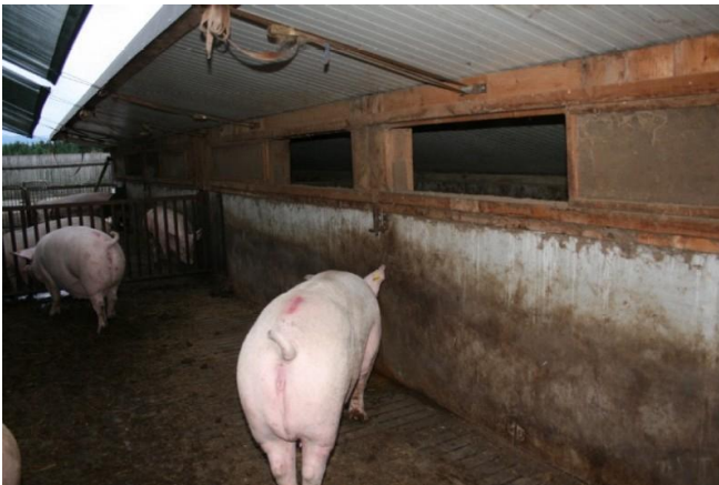
Abb. 10: Im Sommer sind die Holzschieber zur Belüftung ganz geöffnet.
